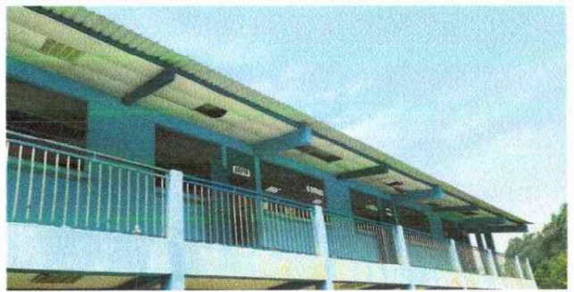
Foto 6: Sustitucion de canal de PVC
