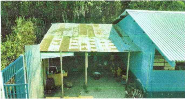
Foto1: Sustitucion de lamina de cocina
