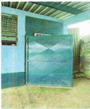
Foto 3: Sustitucion de puerta.
