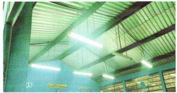
Foto 2: Sustitucion de cableado y lamparas
